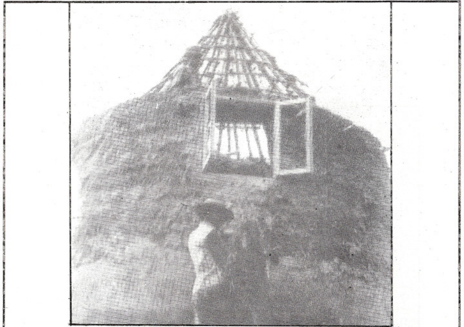
Photo 5 : Opération de pose de la charpente en bambous de silo. (Rabat)
