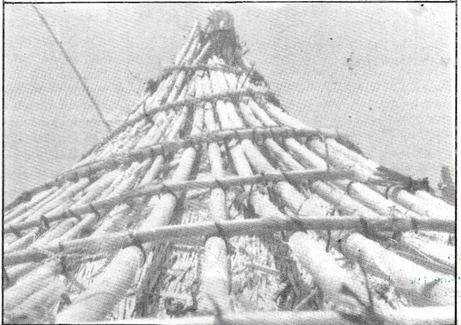
Photo 6 : Vue de près du sommet du silo en matériaux locaux des roseaux, montrant le tapis de jonc et le maillage
