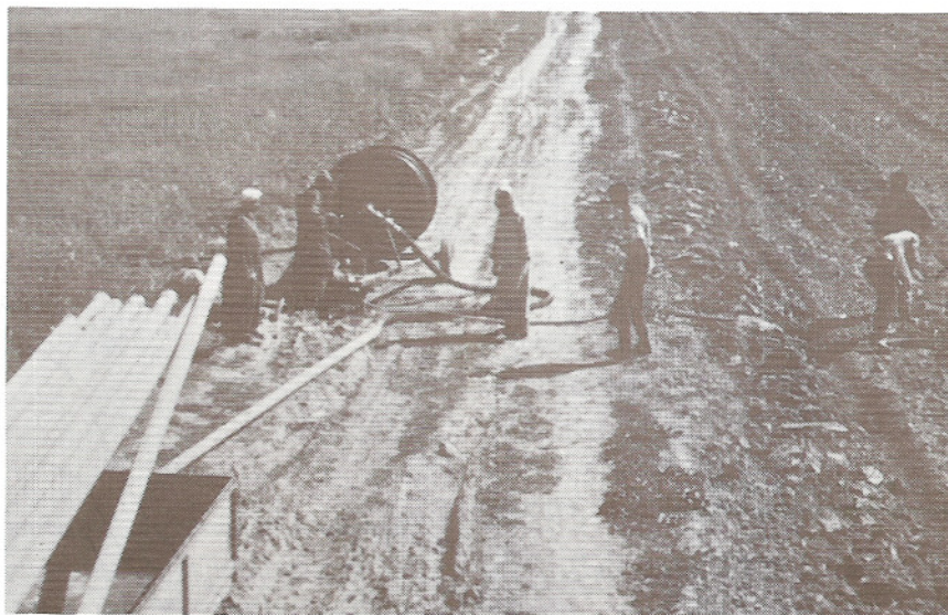
Installation de l'essai sur l'irrigation d'appoint à Kariat-Tissa.
