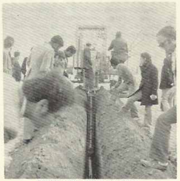
Machine pour poser des drains
