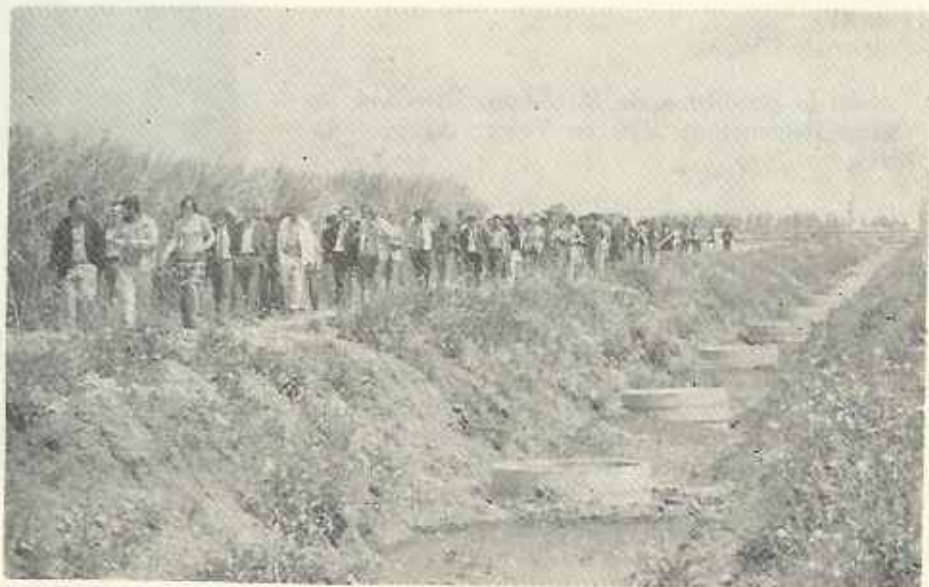
Vue de la parcelle expérimentale et de l'installation de drainage
