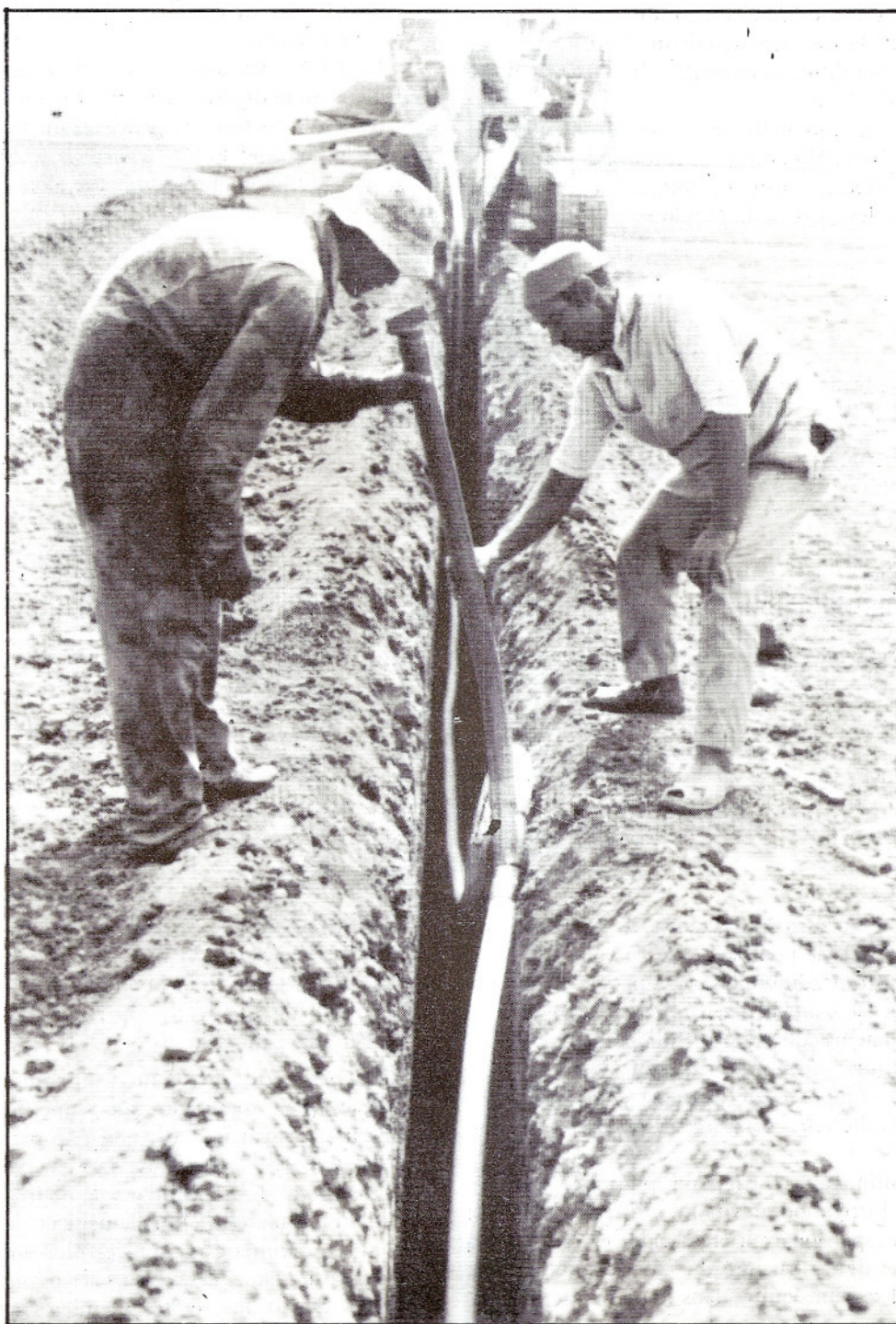
— Pose mécanique de tuyaux souples.
