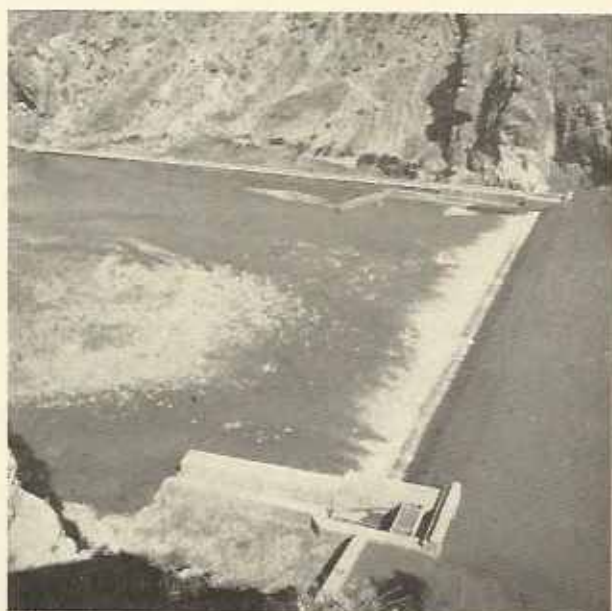
Photo N° 6 Prises modernes des séguis Lakhzainia et Taglaout sur l'oued Tessaout.
