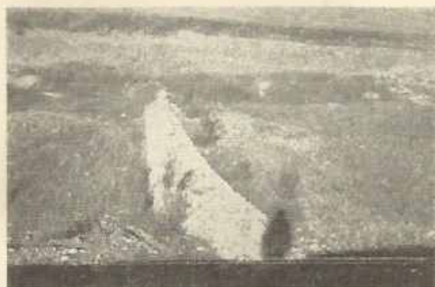
Photo N° 1 Un barrage en perré non maçonné.
