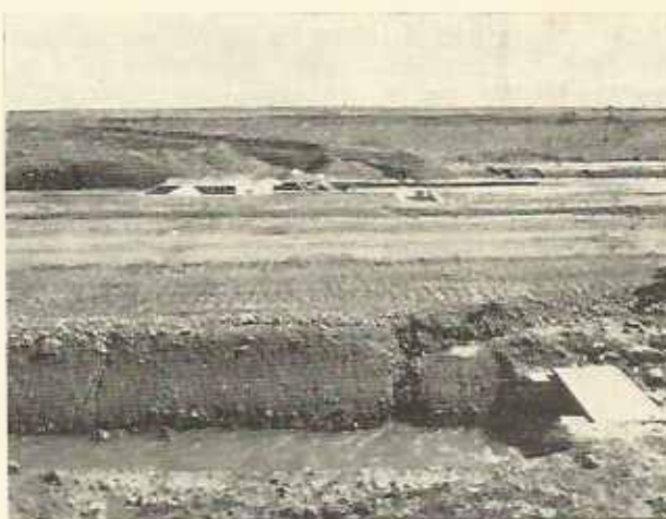
Réalimentation de séguía traditionnelle à partir du canal primaire (ici en rive gauche).
