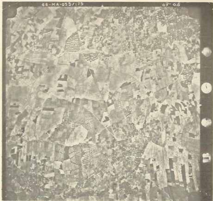
Un secteur traditionnel avant l'aménagement, Sahrij. Vue aérienne.
