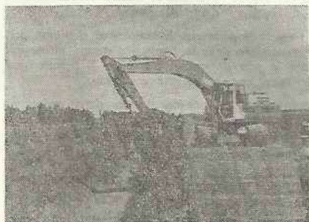
3. Le curage mécanique permet un nettoyage complet du drain des mauvaises herbes et de la vase mais constitue une opération lente et coûteuse.
