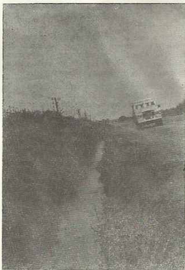
2. Un fossé propre assure le drainage des eaux excédentaires.
