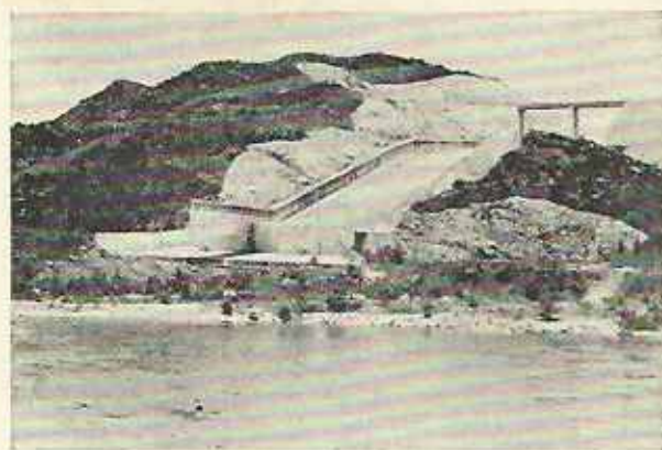
Barrage du Kastrahi sur le fleuve Acheloos (évacuateur de crues)
