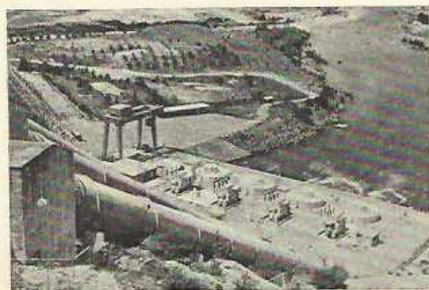
Barrage de Kastraki sur le fleuve Acheloos (conduites forcées et turbines électriques)
