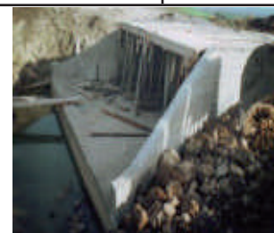
Figure 4: La situation actuelle de l'avancement des travaux
