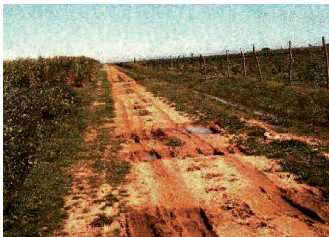
Piste reliant le bloc 23 à 25 secteur EST
