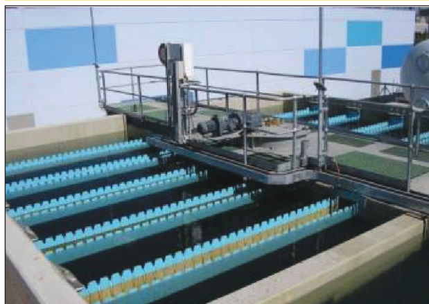
Figure 7: Perth – filière de traitement des eaux de lavage des filtres du prétraitement (clarification épaissement sur Densadeg, déshydratation par centrifugation)
