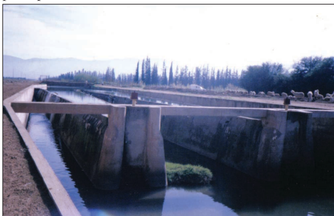
Photo n°1: nouveau giraudet remplaçant la vanne Amil
