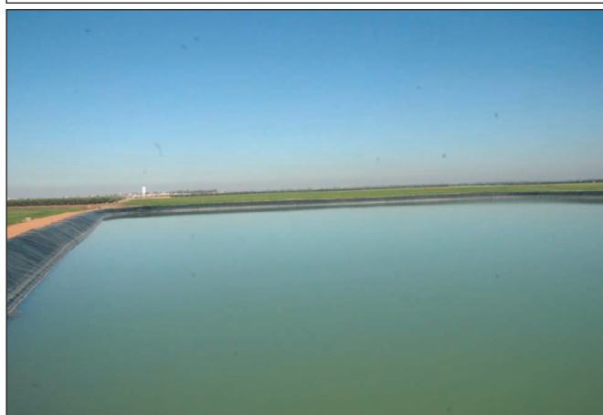
Photo n°3: Bassin d'accumulation d'eau au niveau d'une exploitation à la suite de la reconversion du système d'irrigation gravitaire
