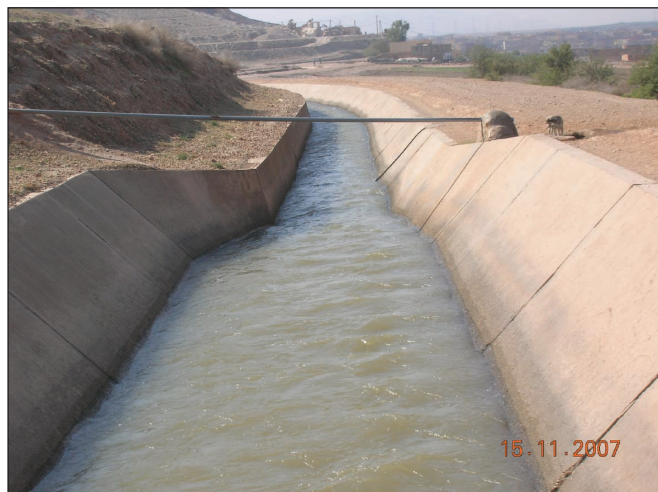
Photo n°4: accentuation de la vitesse d'écoulement à l'entrée du tronçon à forte pente
