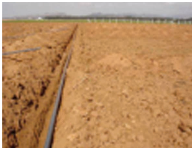
Pose de conduites PVC
