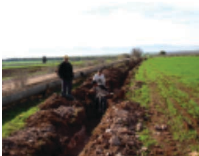
Terrassement d'une tranchée
