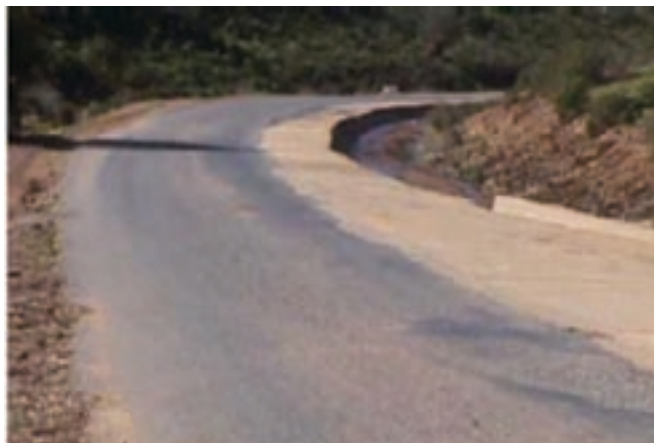
Figure 3: Accotement bétonné bien réussi
