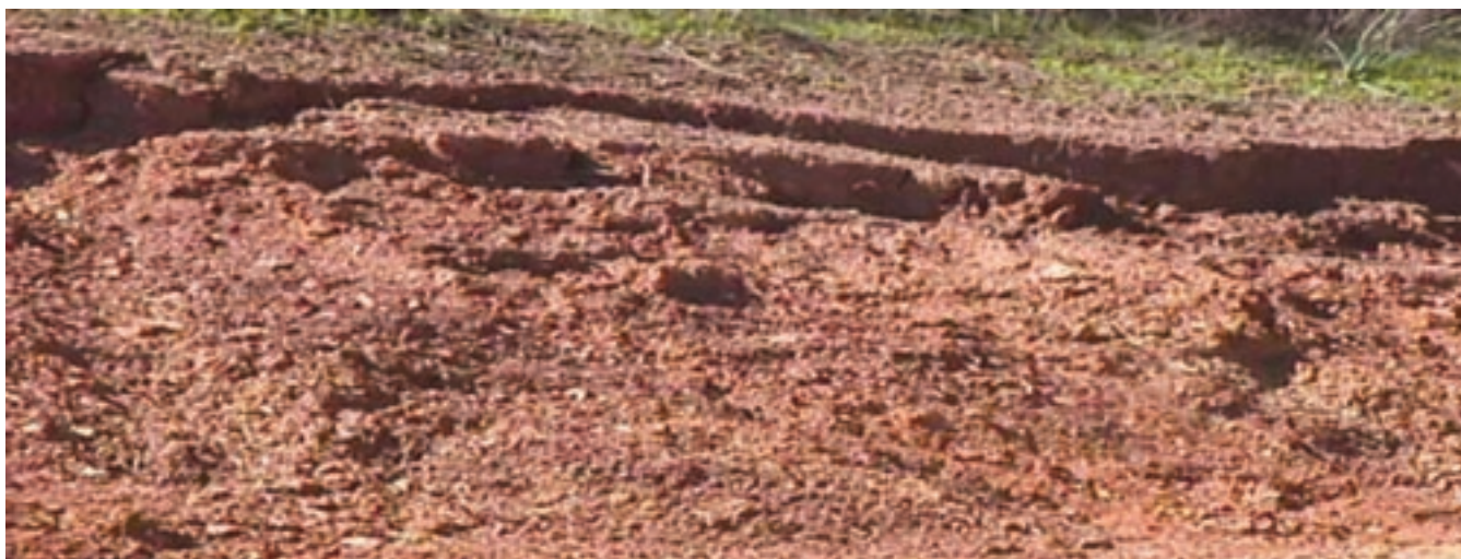
Figure 5*: Glissements survenus pendant la construction de la RP 3333 -Mars 2006-
