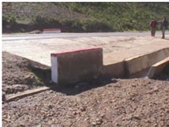
Figure1: Buse en CAO Complètement enterrée
