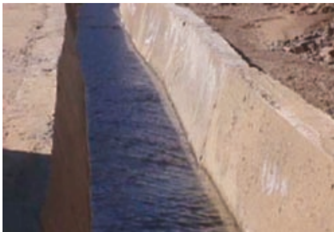
Figure 2: Fossé bétonné assurant son rôle
