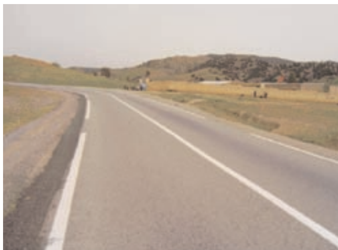
Epaufrures traitées en EAF sur la RN8 à Khénifra
