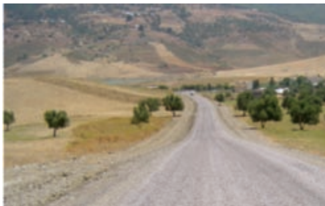
Couche de roulement en enduits superficiels
