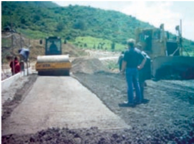
Photos 3 et 4: Mise en œuvre du BCR frais (étalage et compactage) pour la préparation d'une planche d'essais (Tunisie) ([20])
