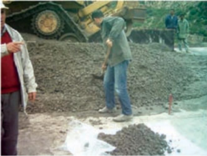
Photos 1 et 2: Etat du BCR frais lors de son déversement pour la préparation d'une planche d'essais (Tunisie) [20]
