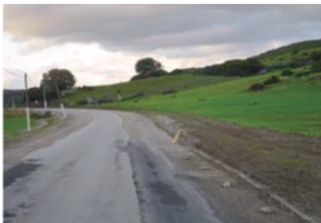
Purges latérales et reconstitution du corps de la chaussée
