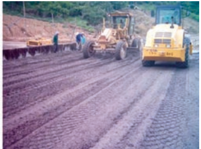
Photos 3 et 4: Mise en œuvre du BCR frais (étalage et compactage) pour la préparation d'une planche d'essais (Tunisie) ([20])
