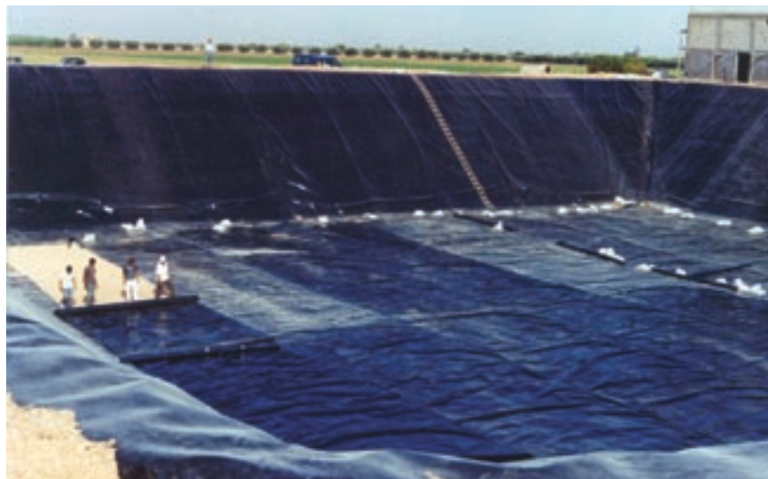
Photo n° 3: Mise en place des géomembranes dans un bassin de stockage
